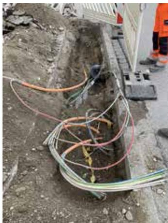
**Verlegung des Breitbandanschlusses zur Grundschule Flintsbach. Die Glasfaser Breitbandkabel liegen zur Montage im vorbereiteten Schacht bereit.**
