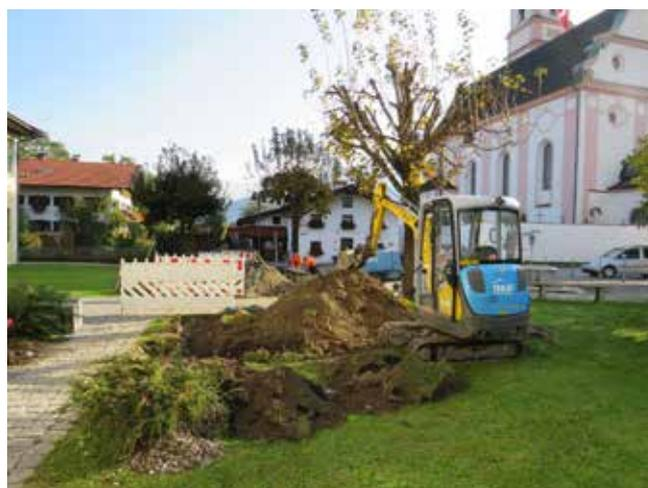
*Verlegung des Breitbandanschlusses zur Grundschule Flintsbach. Erdarbeiten der Fachfirma zur Aufnahme des Breitbandkabels.*
