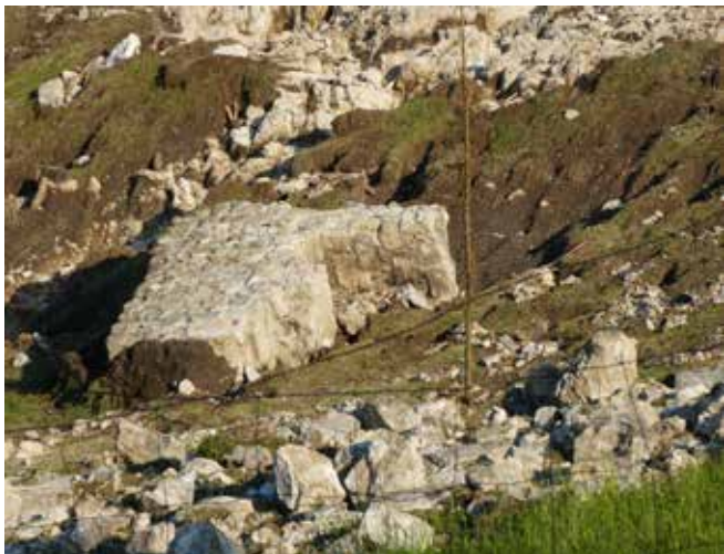
Ein Teil der sanierten Burgmauer, den das Hochwasser bis zum Hangauslauf (30m vom nächsten Haus entfernt), spülte
