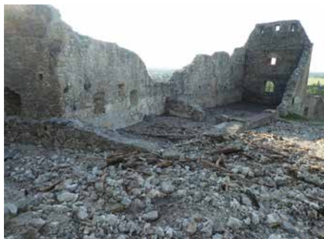
Die sanierte Burganlage Falkenstein sollte im Herbst beim Tag der offenen Tür im neuen Glanz präsentiert werden. Jetzt klappt eine Lücke in der historischen Mauer, das Gelände ist mit Schutt und Geröll übersät. Geologen und weitere Fachleute prüfen intensiv die gesamte Gefahrenlage.
