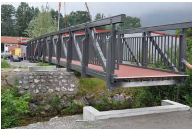
Die neue Brücke über den Griefenbach für Fußgänger und Radfahrer, welche die Orte Brannenburg und Flintsbach verbindet, wird mit einem Schwerlastkran eingehoben. Im Hintergrund das Flintsbacher Gewerbegebiet „Am Griefenbach“.
