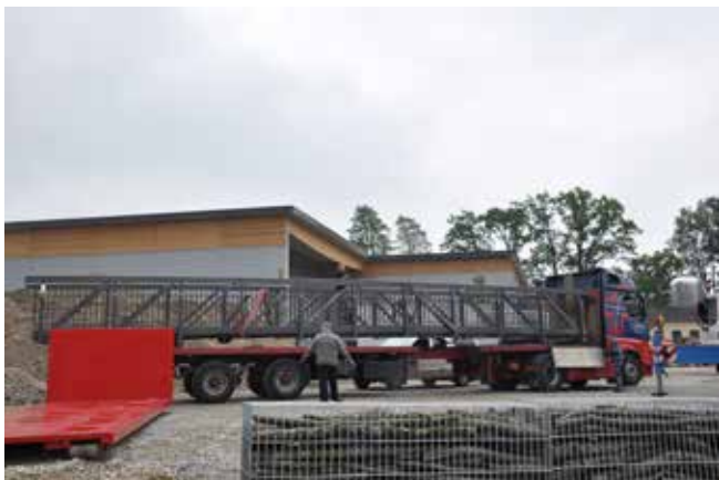
Die 17 Meter lange Brücke wird mit einem Tieflader angeliefert.
