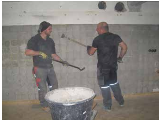
Bei der Entkernung der Schwesternküche, aus der eine Werkstatt für demente Männer wird. Links Martin Oberauer, rechts Hubert Scheble, Chef der gleichnamigen Flintsbacher Baufirma. Die geleistete Arbeit im Wert von 1700 Euro wurde gespendet.
