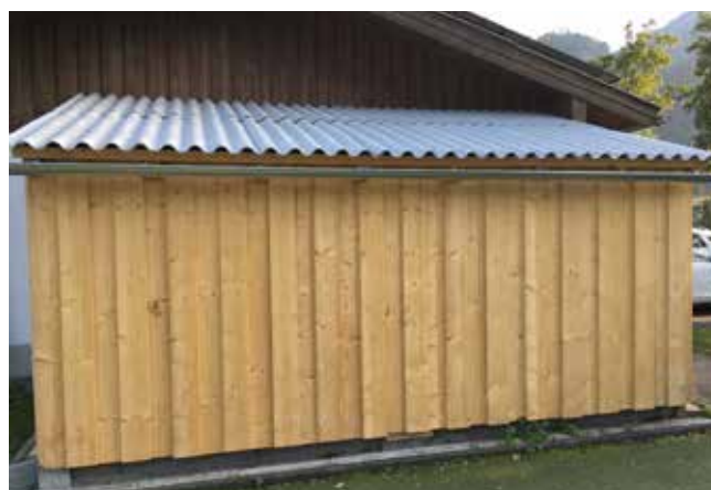
Der neue Anbau dient als Lagerraum
